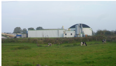
Biogasanlage in Honigsee / Foto: P. Pohlmann
