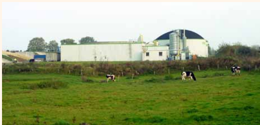
Biogasanlage in Honigsee / Foto: P.Pohlmann
